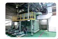
薬液洗浄塔 酸やアルカリ等の薬品を使って臭気を取り除きます。
