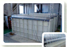
小分離装置 小さな穴のあいた膜によって、微生物や汚泥を分離します。
