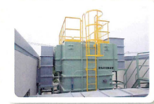
活性炭吸着装置 活性炭の吸着能力を利用して、わずかに残った臭気を完全に取り除きます。
